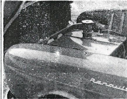
Le «Dauphine» per la Mille Miglia sono dotate di un serbatoio supplementare posto nel cofano anteriore.
