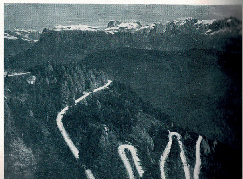
Tornanti della Strada della Mendola (m. 1375)
