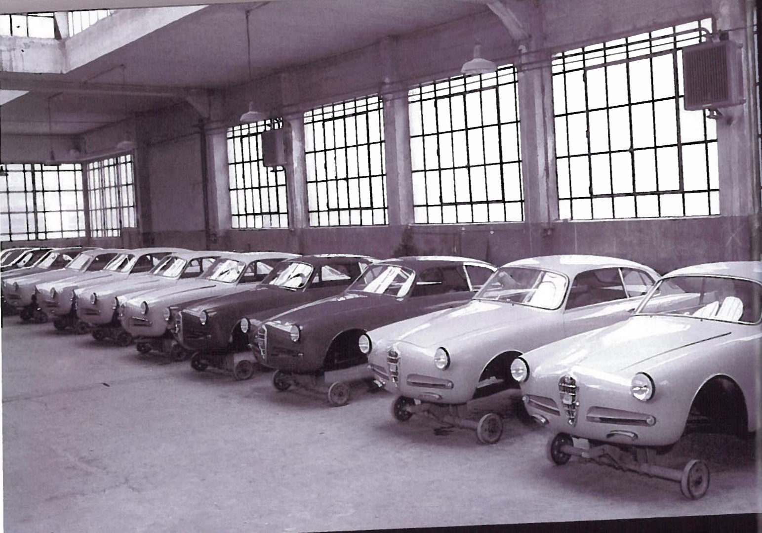
1955年秋半頃になると、ベスキエラ工場が拡大されるとともに、塗装ブースも完成するなど、ジュリエッタの量産体制は格段の進歩を遂げたことになる。もちろんベルトーネは手抜きだが、そのフィニッシュは当時の量産車としてはかなり上質なものであった。また1956年以降には、ベルトーネが独自にフォグランプやホイールリング、フェイスピンナー付ホイールキャップなどを特別装備したドレスアップ版も限定製作されることになった。
