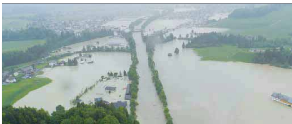
Ein Großteil Kössens stand 2013 meterhoch unter Wasser.
