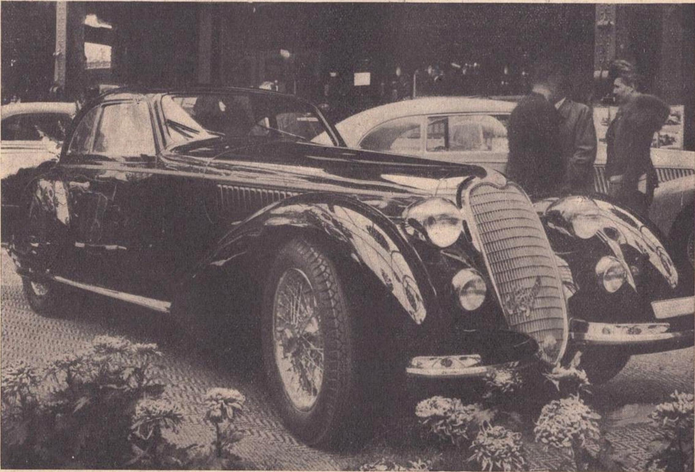
Anche la stampa estera specializzata si è espressa entusiasticamente nei riguardi di questa *Alfa Romeo* 2900 cc. compressore che deve gran parte delle sue elevatissime possibilità velocistiche alla speciale carrozzeria profilatissima e leggerissima approntata con largo uso di leghe leggere dalla milanese carrozzeria
