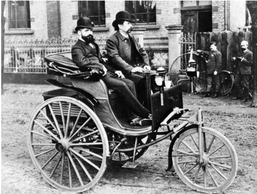
Benz Patent-Motorwagen, Modell 3, 1886. Das Bild zeigt Carl Benz am Steuer seines Patent-Motorwagens, neben ihm sein späterer kaufmännischer Mitarbeiter Josef Brecht. (© Daimler AG)
