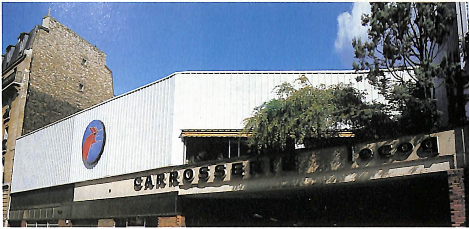
Les ateliers de la rue Charles Schmitt : 4 500 m 2 à l'abri de l'écusson Mafra...
